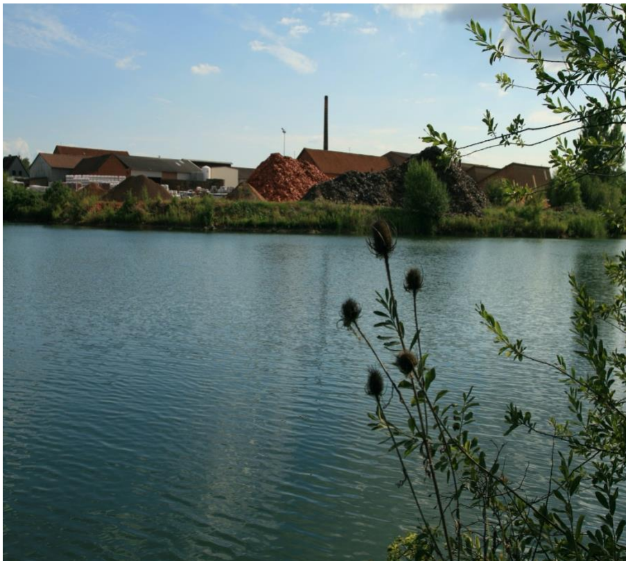
Südwestufer mit Ziegelei, von der Halbinsel im N gesehen 30.07.2010
