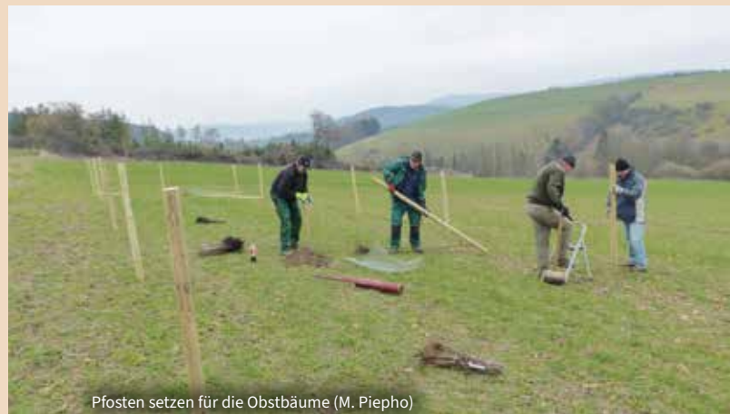
Pfosten setzen für die Obstbäume (M. Piepho)
